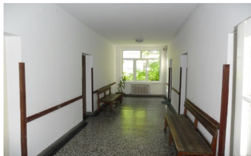
Slika 10: Izvršeni molerski radovi u hodniku suda
