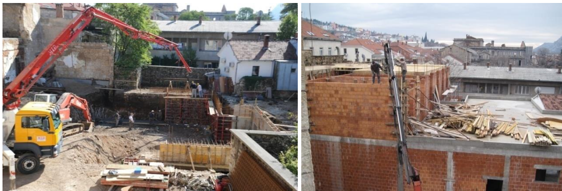
Slike 6 i 7: Građevinski radovi na novoj zgradi Općinskog suda u Mostaru
